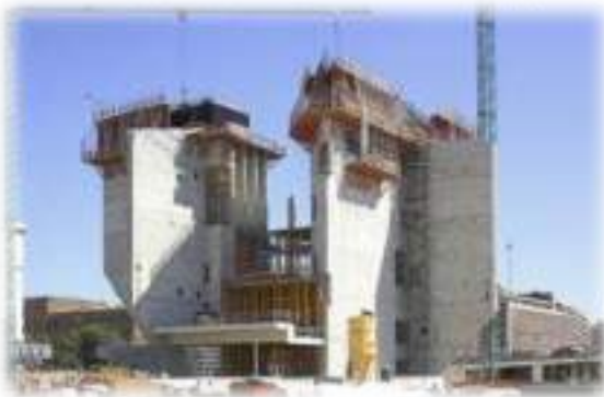
Imagen 23 Proceso de construcción
