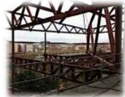
Imagen 24 Estructura de acero voladizo
