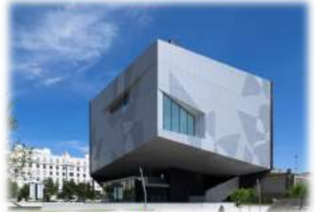
Imagen 21 Vista exterior Caixa Forum
