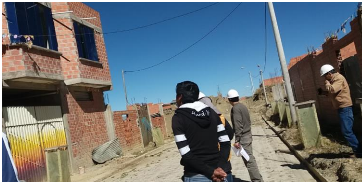
Fotografía N° 3. Inspección con la auditoría.
