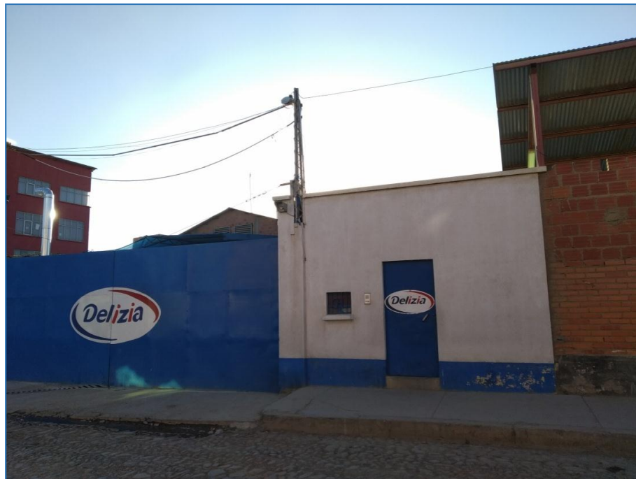
Fabrica industrial de productos Lactios (La Delicia), Camino a Viacha entre avenida Jaime Mendoza, donde profesionales electromecánicos trabajan en esta empresa.
