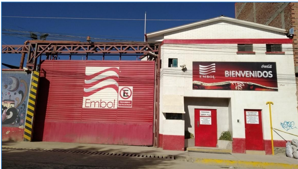
Empresas Industrial privada de bebidas, donde sus instalaciones de producción son totalmente automatizadas, donde profesionales Electromecánicos trabajan.
