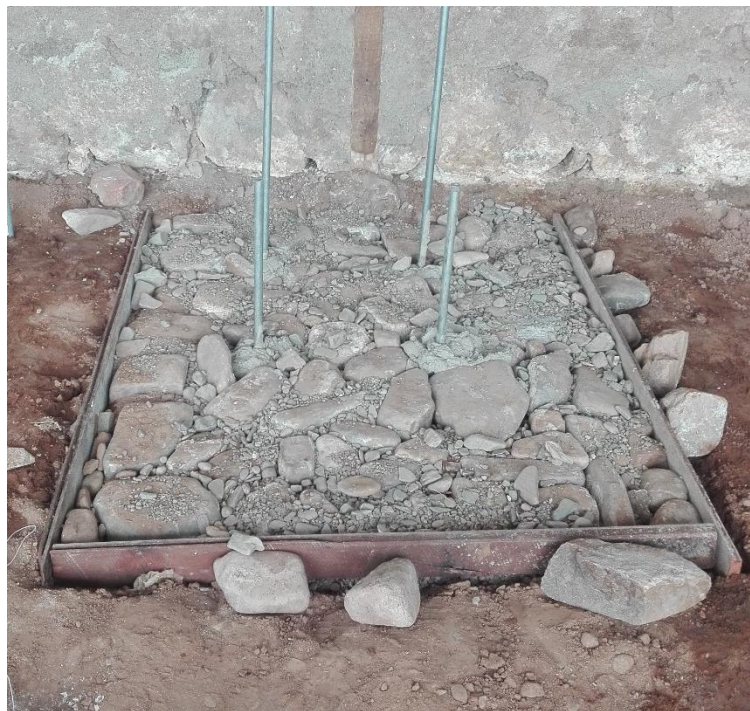
Colocado de cemento para el brete
