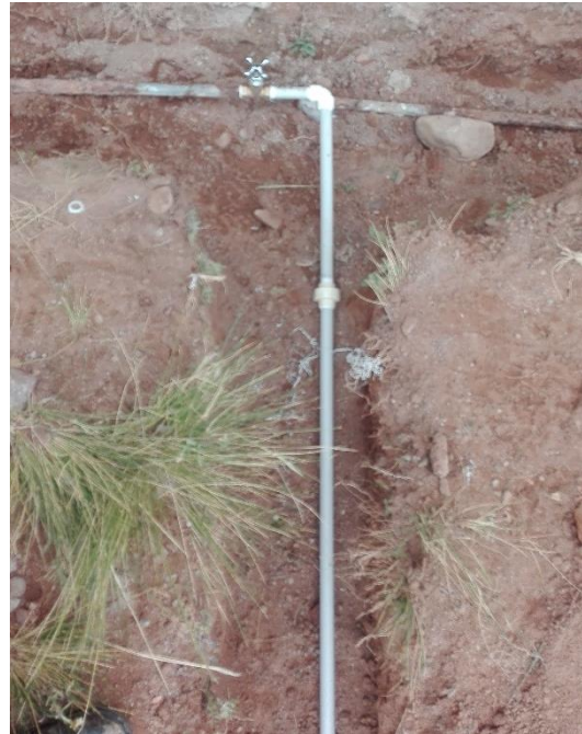
Instalación de agua para el laboratorio
