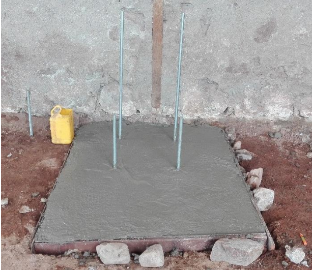
Vaciado de la mezcla para el piso de brete
