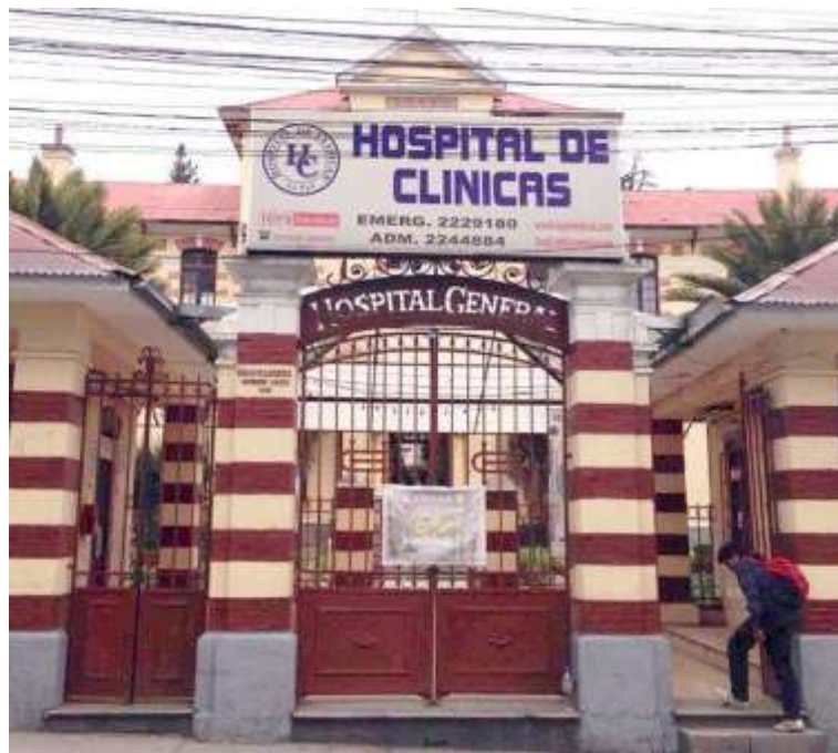
Ilustración 10 – Panorama frontal del Hospital de Clínicas
