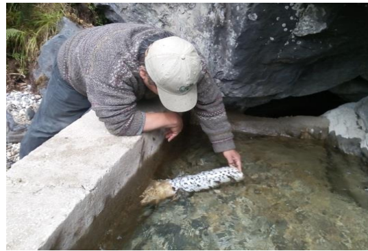
Limpieza del sistema hidráulico
