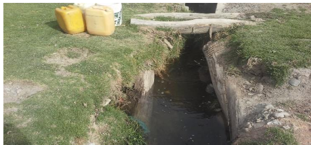
Figura 7 Pozo de riego
