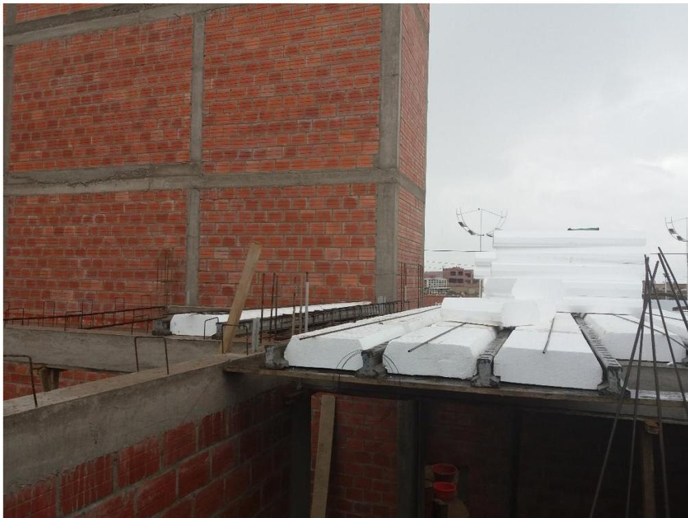
*Imagen 3 Vista del pre vaciado de losa*
