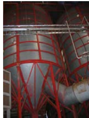
SILOS DE ALMACENAMIENTO
