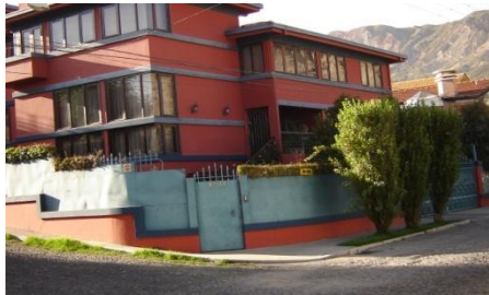
Imagen de la vivienda del General Ing. Civil Augusto Sánchez Valle, Zona: Calacoto
