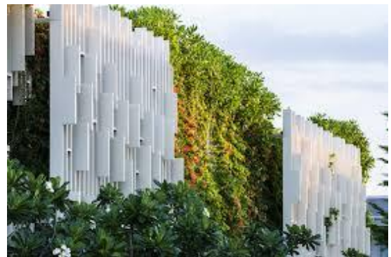
Vista exterior fachada Sur
