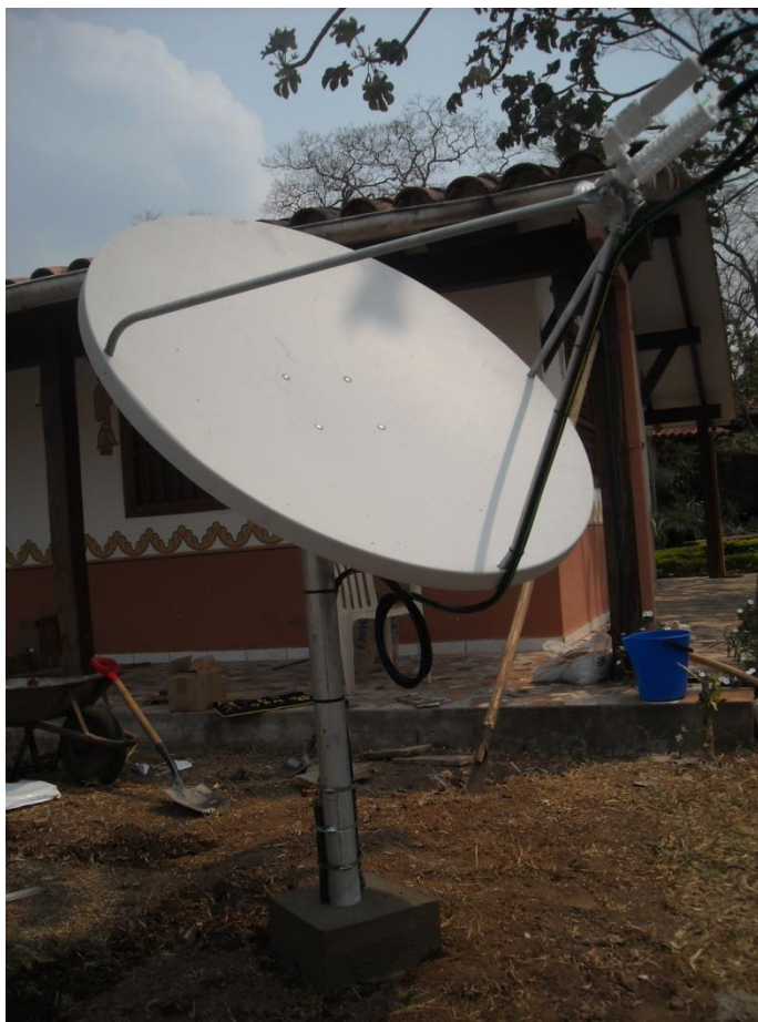
Figura 33. Imagen fotográfica de una antena ya montada.
