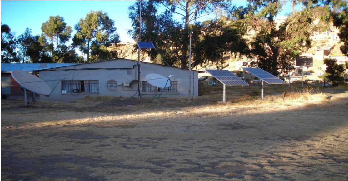
Figura 41. Imagen de una estación ya culminada.
