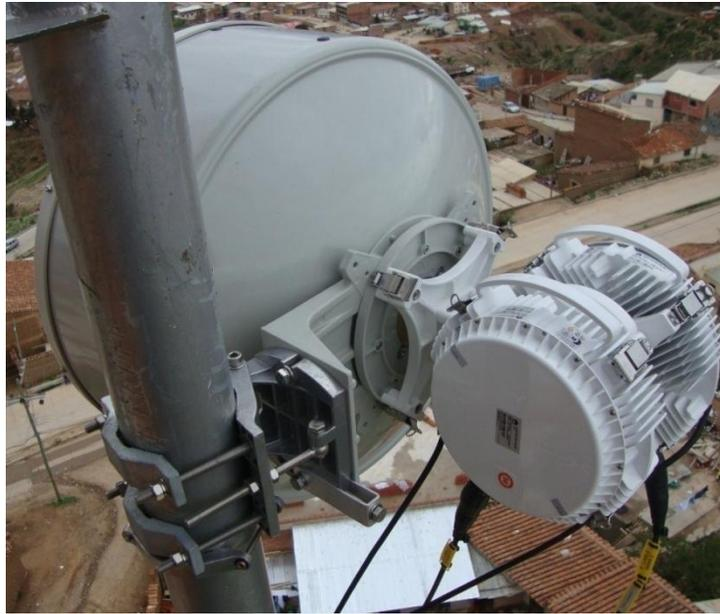
**Figura N° 25.** Antena de Radio Enlace Huawei OPTIX RTN 620
