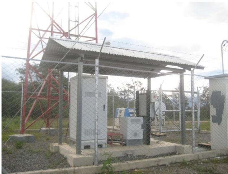
**Figura N°28.** Fotografía de los equipos de la radio base Dorado (Choacollo)
