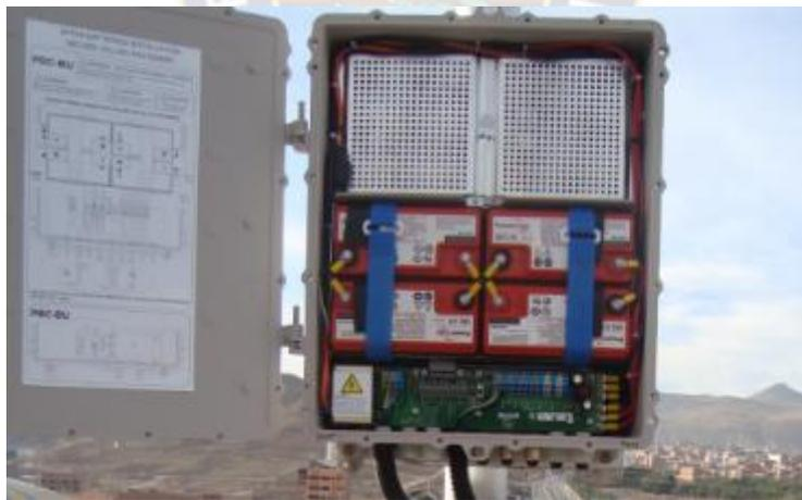
**Figura N°14.** Fotografía de la PBC-MU con su banco de 4 baterías
