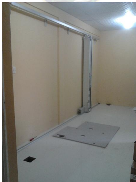
fig. 2.24 Colocado de Base de la mesa y columna
