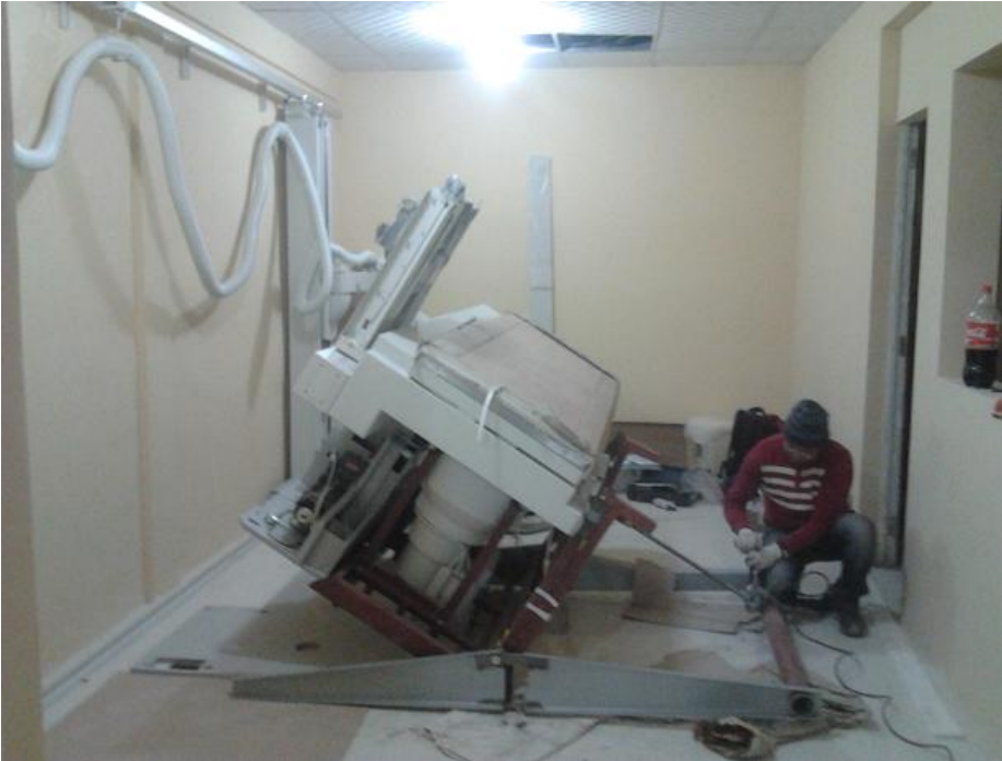
fig. 2.25 Colocación de la mesa mediante el sistema de posicionamiento
