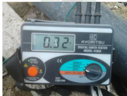
fig. 2.20 Fotografía de medición de impedancia de tierra in situ
