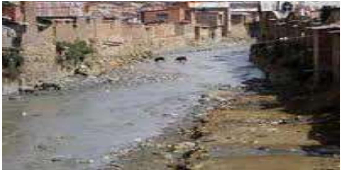
Imagen N° 5 Contaminación de aguas mina Huanuni.
