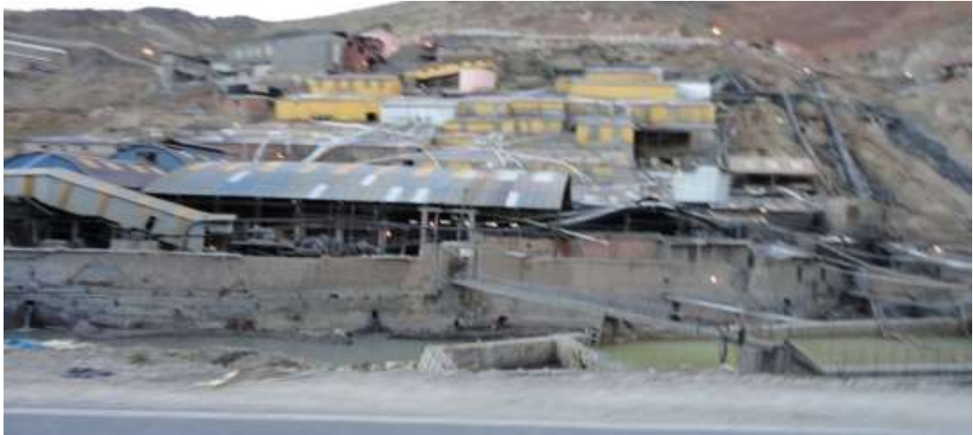
Imagen 4: Mina Huanuni Fuente: Trabajo de Campo
