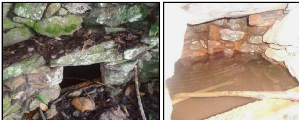
Figura 6. Vertiente para recolección de agua sin cloro
