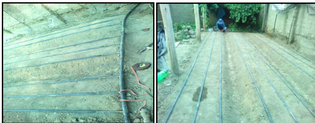
Figura 26. Instalación del sistema de riego por goteo
