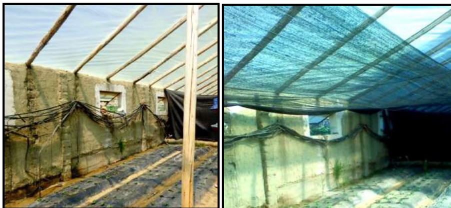
Figura 30. Colocado de malla semi-sombra
