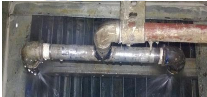
FOTO 10 ATOMIZADOR REDISEÑADO
