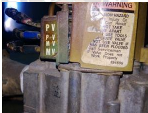
FOTO 19 ELECTRO VALVULA DE GAS DE CALEFON
