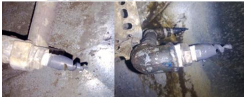
FOTO 17 ATOMIZADOR ANTES DEL DESMONTAJE Y DESPUES DEL MONTAJE
