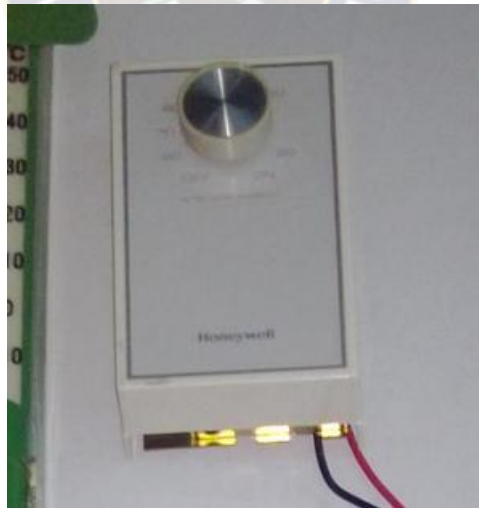
FOTO 14 SENSOR DE HUMEDAD
