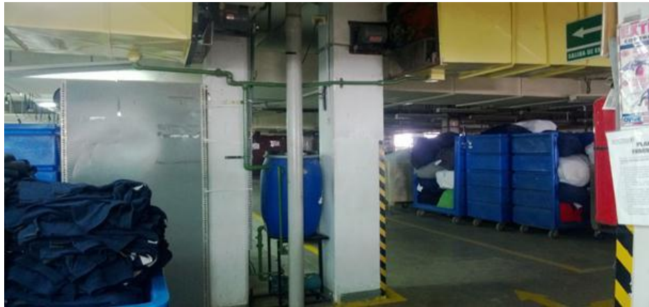
FOTO 1 SISTEMA HUMIDIFICADOR REDISEÑADO Y MONTADO
