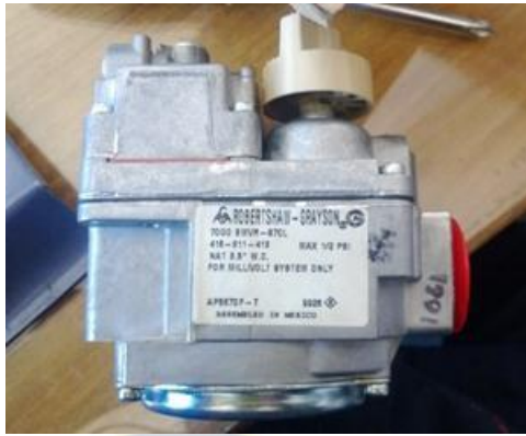
FOTO 20 ELECTRO VALVULA DE GAS DE CALEFON
