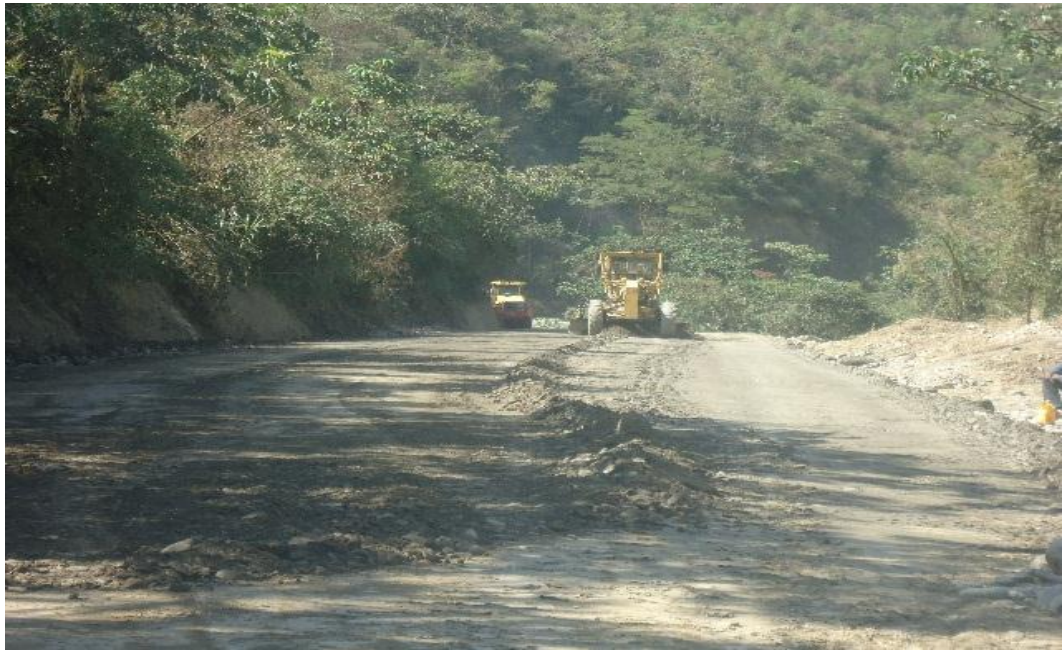
Foto: Perfilado y Compactado
