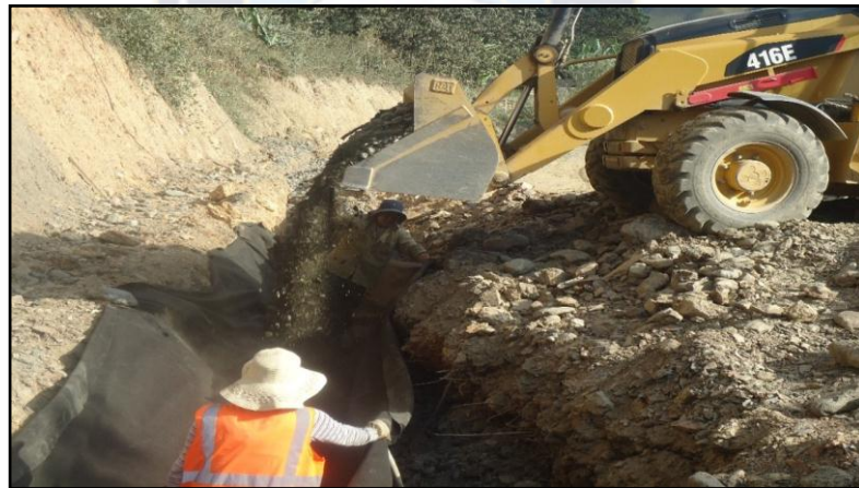
Figura N° 7 Proceso constructivo de subdren.
