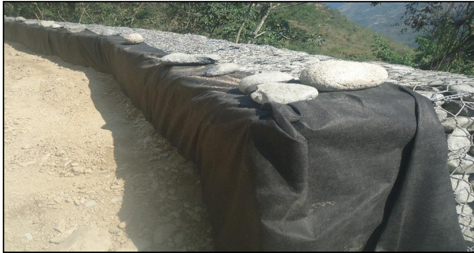
Figura N° 24 Relleno de capas del proceso constructivo
