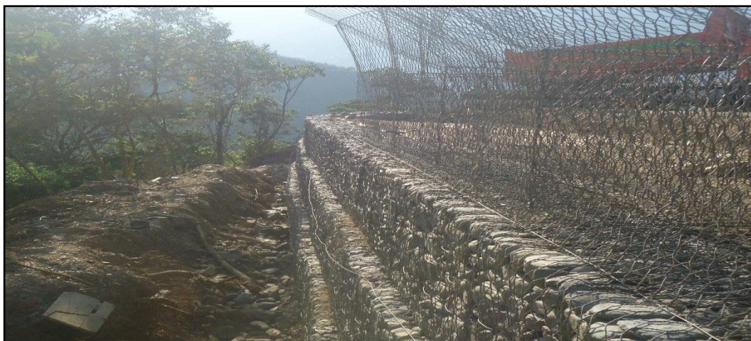
Figura N° 23 Talud de estabilización con terramesh
