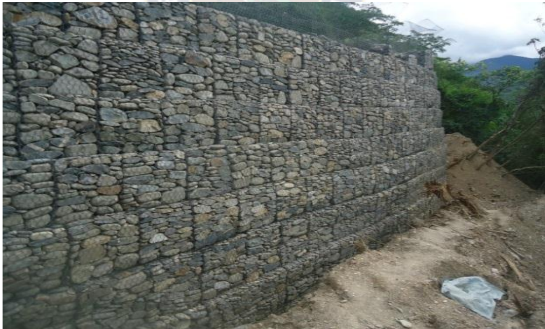
Foto: Construcción de Terramesh prog. 1+200
