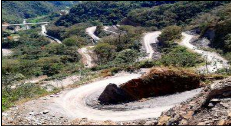
Figura N° 2 Construcción de terraplén y subrasante
