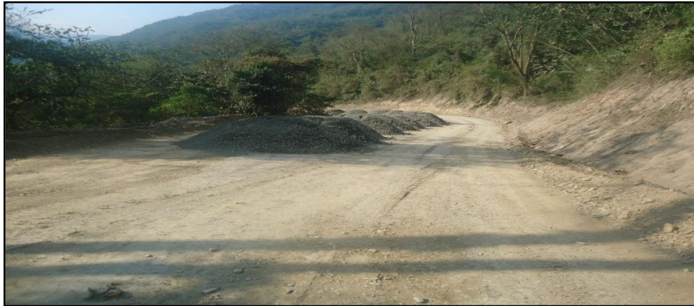
Figura N° 4 Material granular de capa base.
