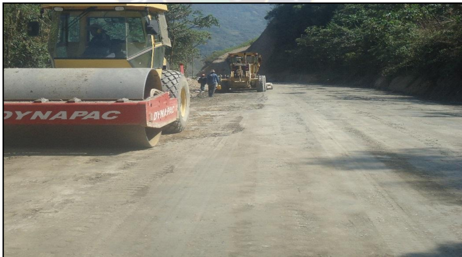
Figura N° 3 Perfilado y compactado de capa súbbase
