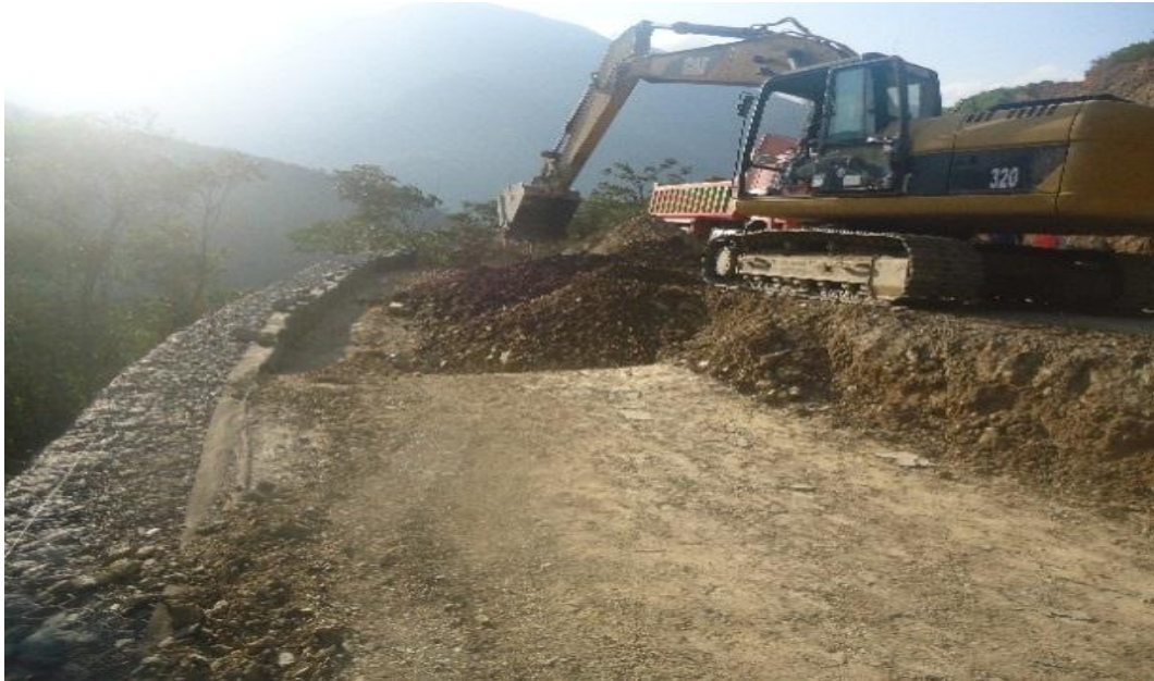
Foto: Colocado de material preparado para capas de subbase y base
