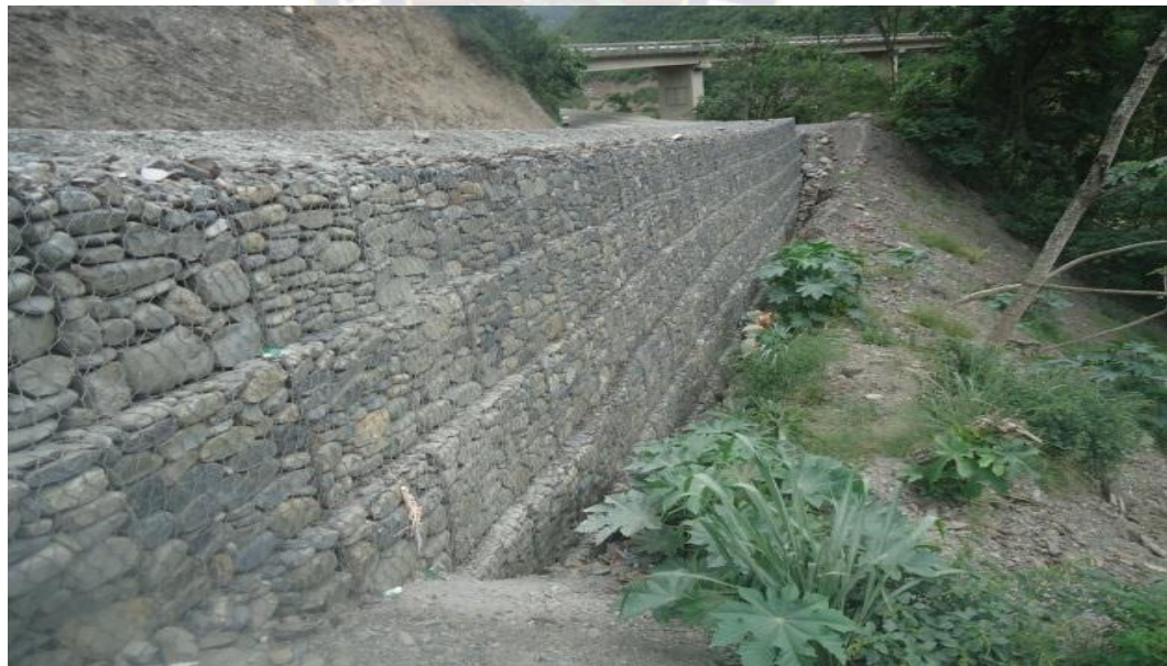
Foto: Acabado de muro terramesh prog. 0+020
