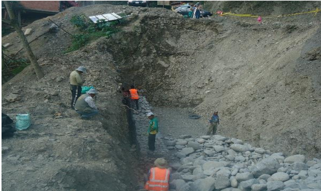
Foto: Excavado para Construcción terramesh system
