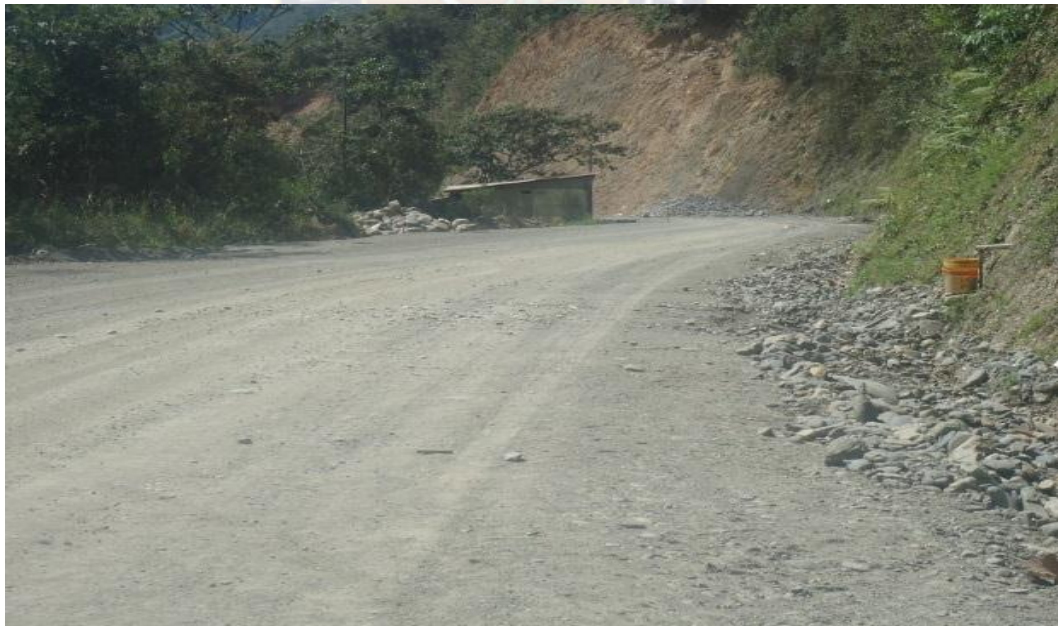
Foto: Plataforma de capa base
