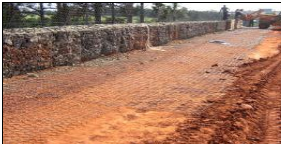
Figura N°17 Llenado de piedra, extendido la cola
