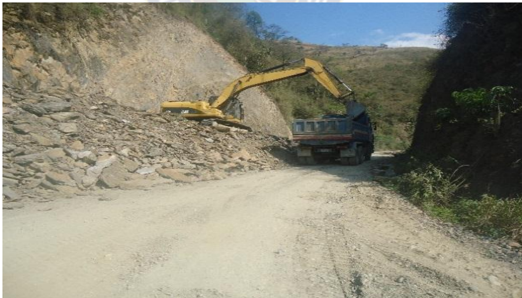
Foto: Corte de talud
