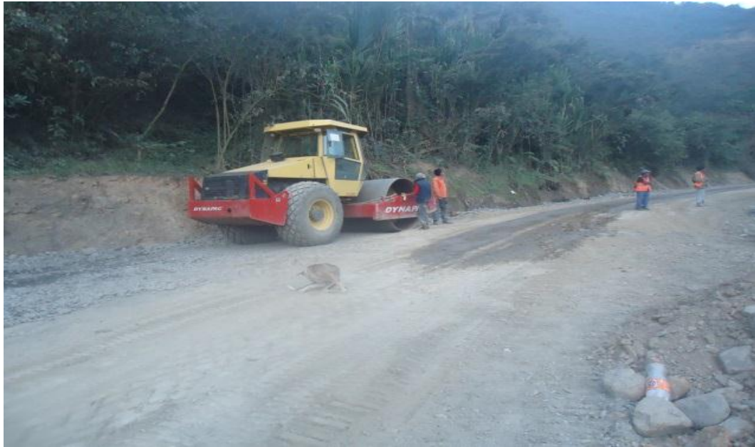
Foto: Compactado de material capa base
