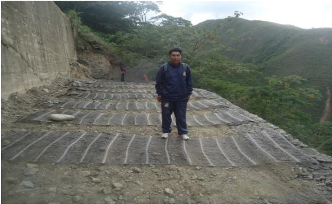
Foto: Extendido de Geo dril de 7m
