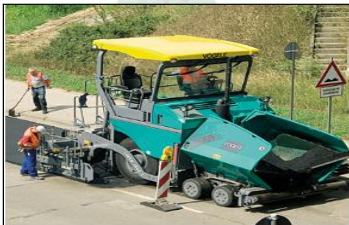
Figura N° 6 Proceso de asfaltado, Maquina terminadora.
