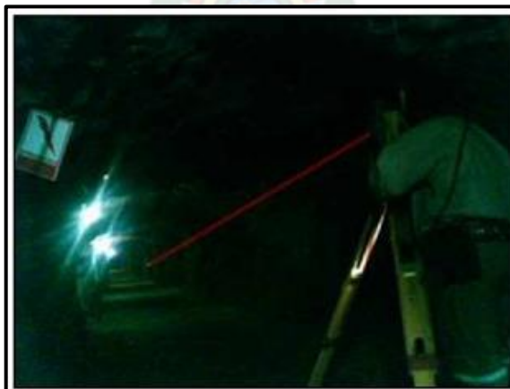
FIG. 40 ALINEAMIENTO DE TARUGOS FUENTE: PROPIA
