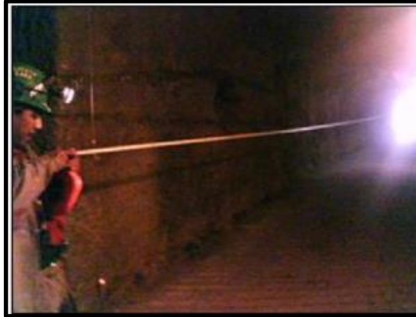
FIG.: 42 TOMA DE DISTANCIA DE TARUGO A TARUGO FUENTE: PROPIA
