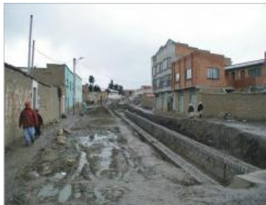
Ausencia de alcantarillado pluvial en el "fin del mundo"
