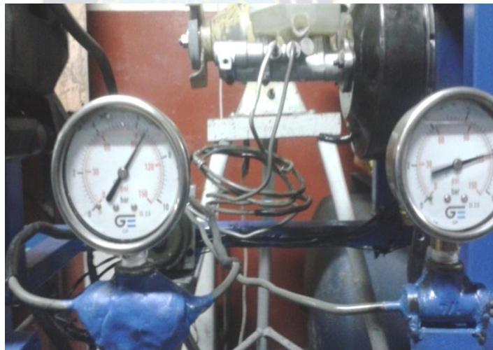
Figura 45 Se verifica la nivelación de presión
